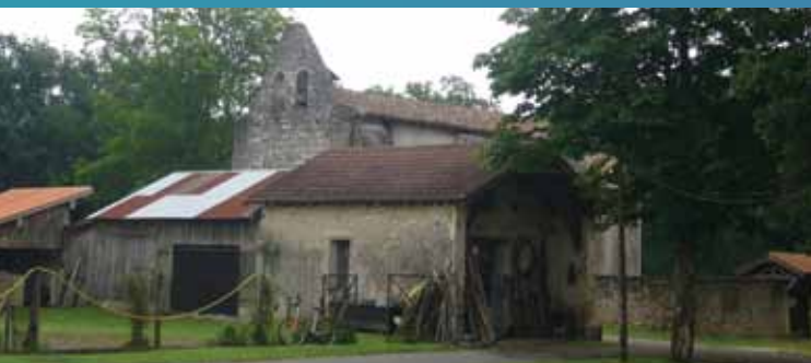
Vue du bâti avant travaux, au premier plan l'atelier communal.
