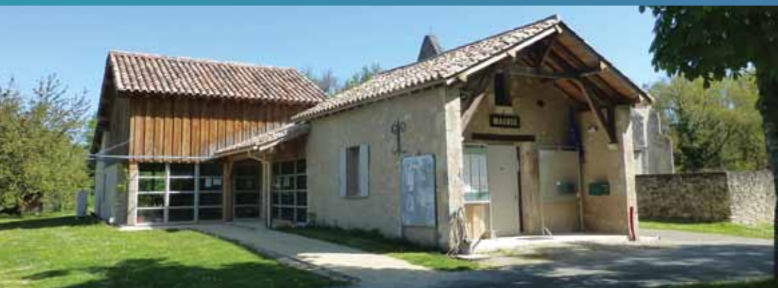
Vue du bâti après travaux, au premier plan l'atelier communal après reconversion, entrée de la nouvelle mairie. D. Dumas architecte
