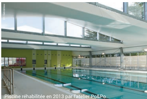
Piscine réhabilitée en 2013 par l'atelier Po&Po
