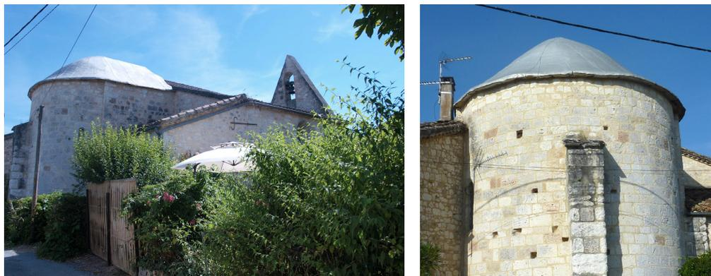
**Nature des travaux réalisés/** La randière en pierre au niveau de l'égout de l'abside témoignait de la nature de la couverture originale, aussi le conseil en amont de l'architecte du CAUE a été de préconiser la réfection de la couverture en lauzes calcaires. Sous la conduite d'un architecte du patrimoine, après la dépose de l'étanchéité et suppression de la chape de pose en ciment, la couverture du chœur est entièrement restaurée en lauzes.
