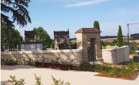
Murs d'enceintes - Saint-Barthélémy-d'Agenais - Lot-et-Garonne
