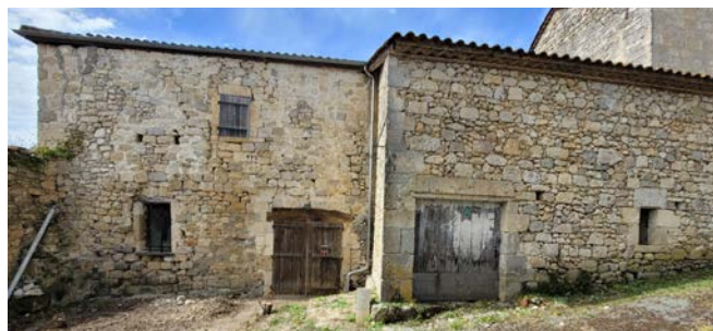
Photos du bâtiment avant les travaux
