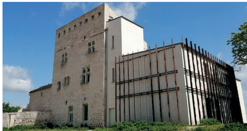
▼ Après les travaux - La Maison Garonne ©Pronaos
